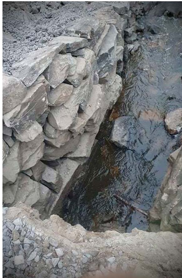
Istandsetting av gammel steinbru over Kåtåa der den renner ut i Glomma.
