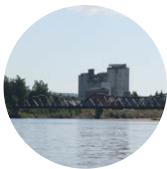
Siloen ved Flisa og Flisabrua.
