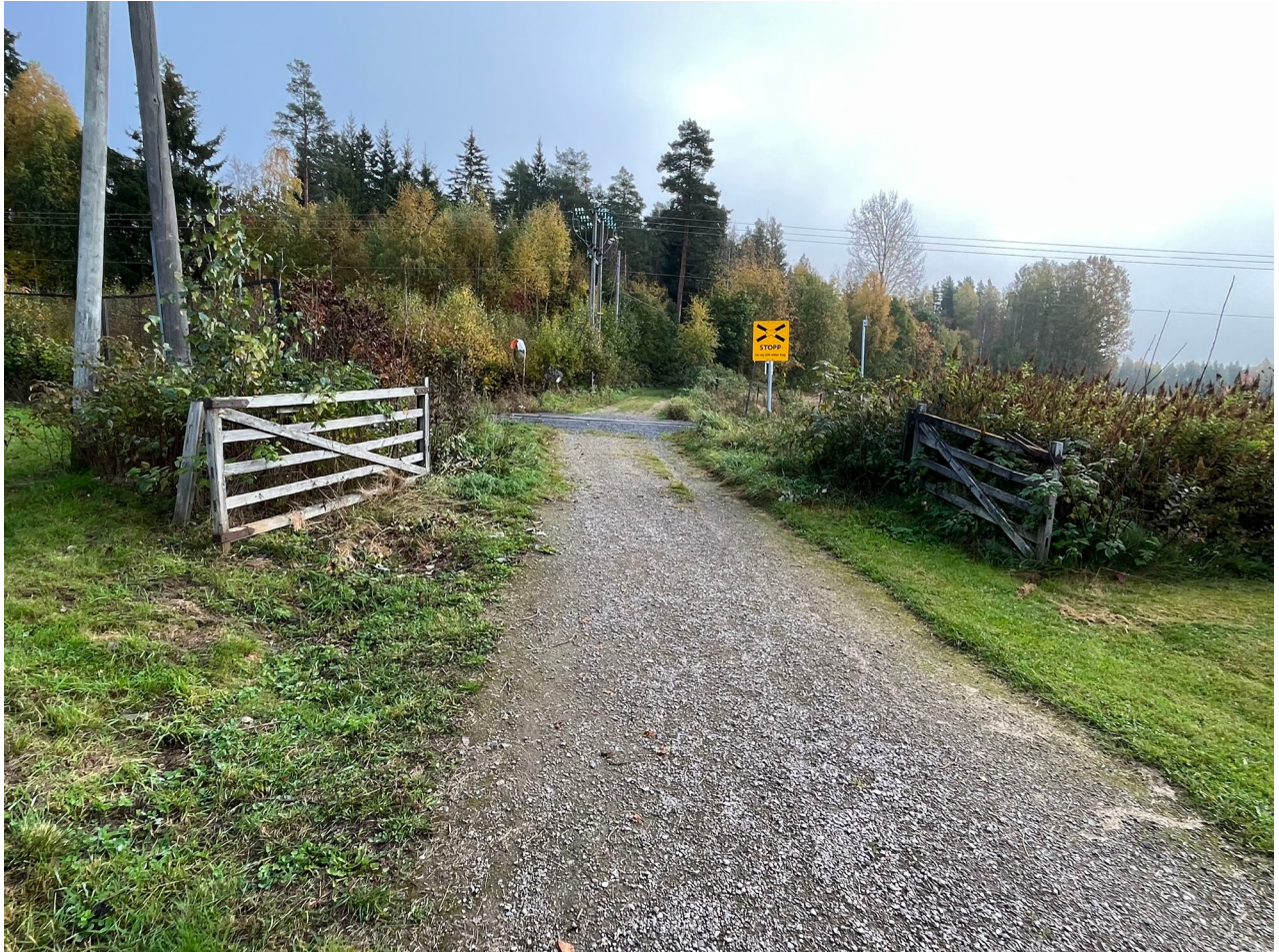
Figur 16: Planovergang ved Teppgutua.
