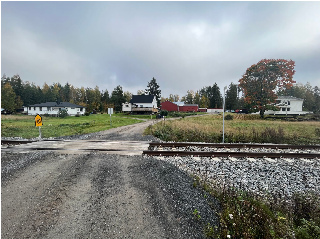
Figur 7: På bildet vises planovergangen lengst mot sør i planområdet. Denne benyttes for adkomst til boliger på østsiden av jernbanen. Denne overgangen skal saneres. (Foto: Sweco)
