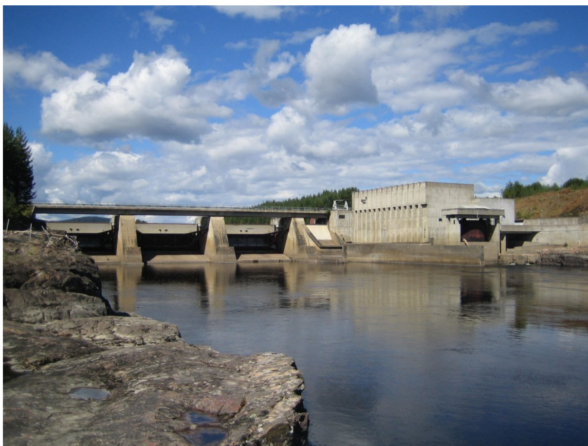
Braskereidfoss kraftverk. Foto, Eidsiva
