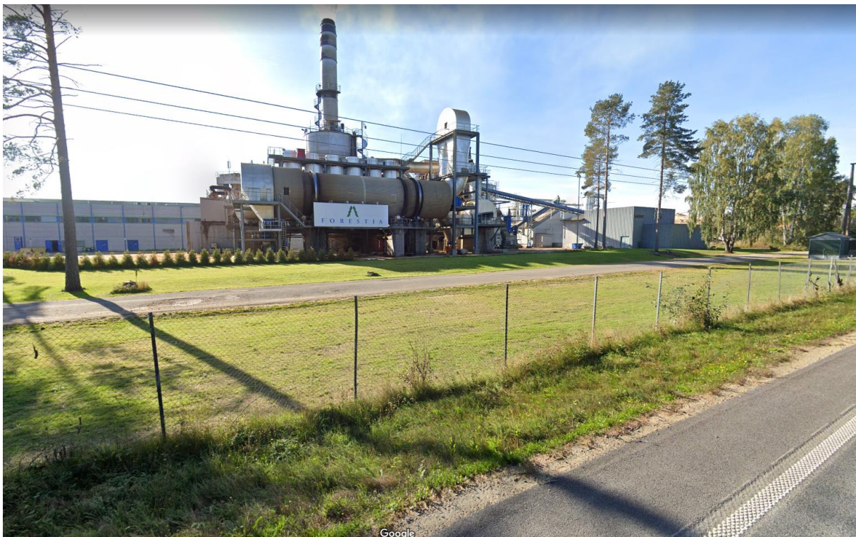
Forestia AS, Braskereidfoss. Sett fra Solørvegen (Rv2). Kilde Google Maps
