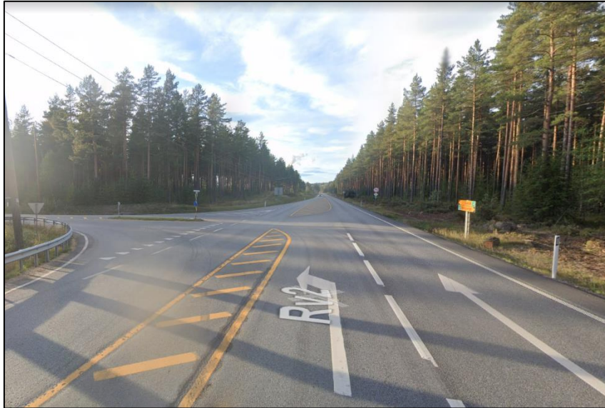
Figur 15. Kryss mellom rv. 2 Solørvegen og fv. 2114 Damvegen.
