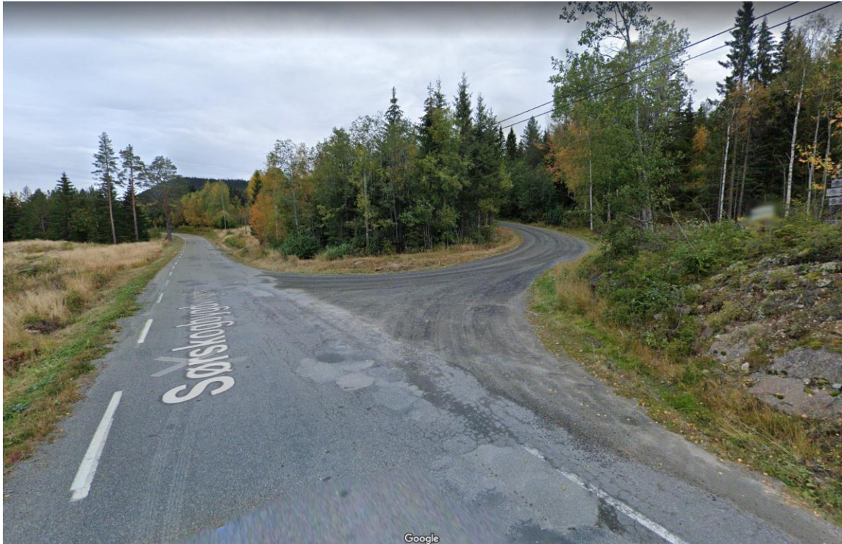
Figur 4. Sørskogbygdvegen, med adkomst opp til eiendommen gnr./bnr.: 81/75.
